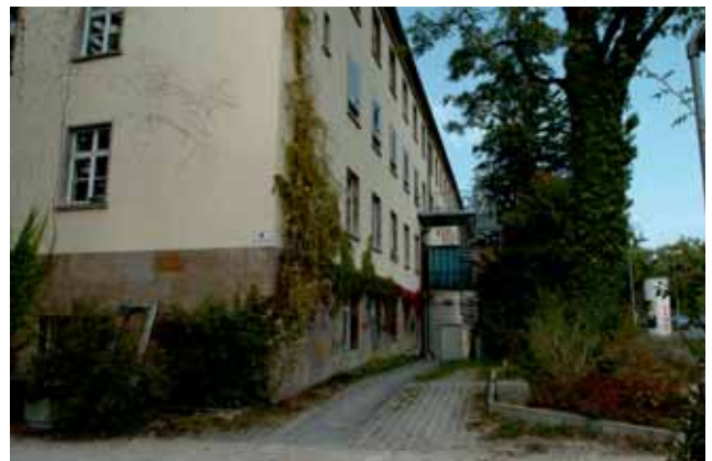
Rückansicht mit Hintereingang zum Saal (hier wird geladen)
